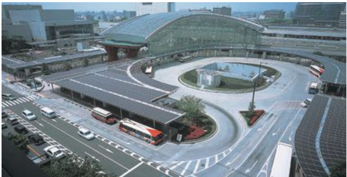
日本 120 KW 光伏建筑一体化项目 金泽市汽车站
