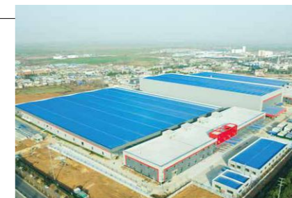
尚德电力滁州基地
