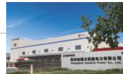
尚德电力常州基地
