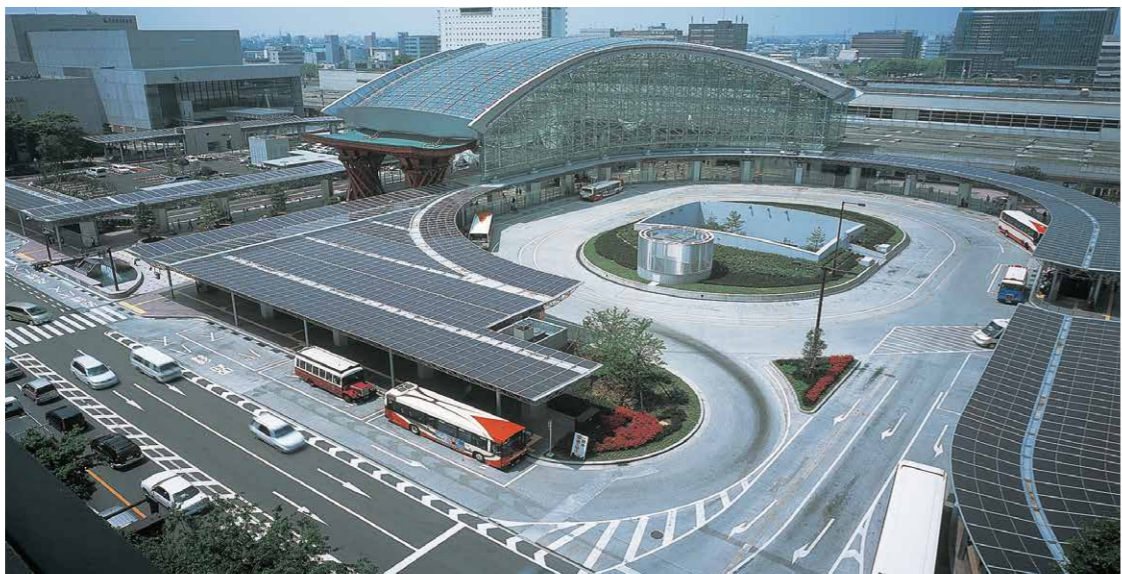
120 KW 日本 金泽市汽车站 光伏建筑一体化项目
