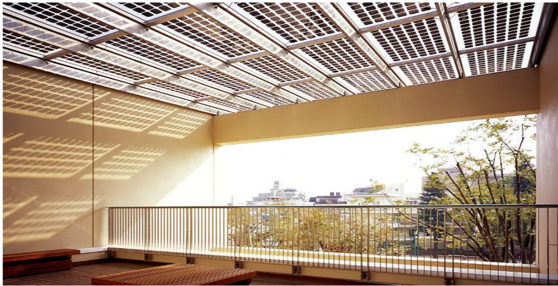
10 KW 日本 光华初级小学 光伏建筑一体化项目
