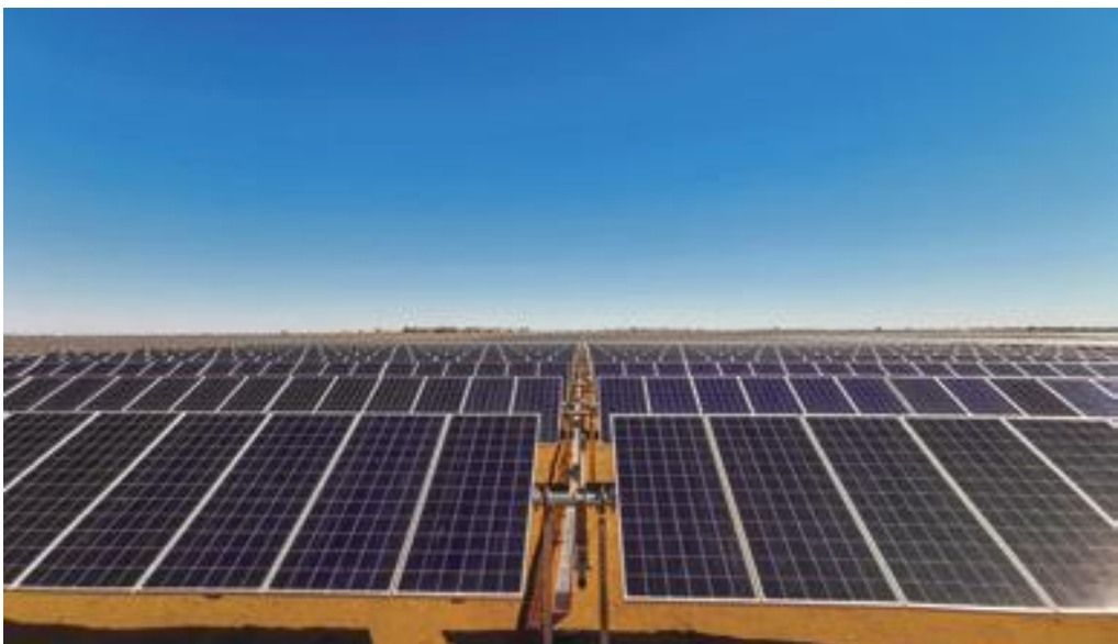
南非 250 MW 太阳能电站项目 Kimberly Droogfontein
