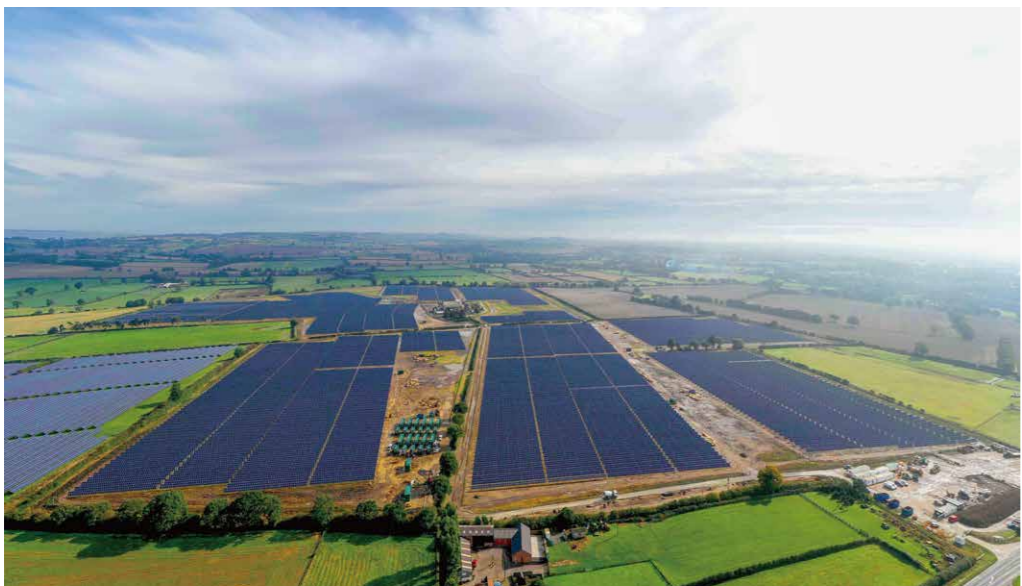
英国 34.7 MW York 太阳能电站项目
