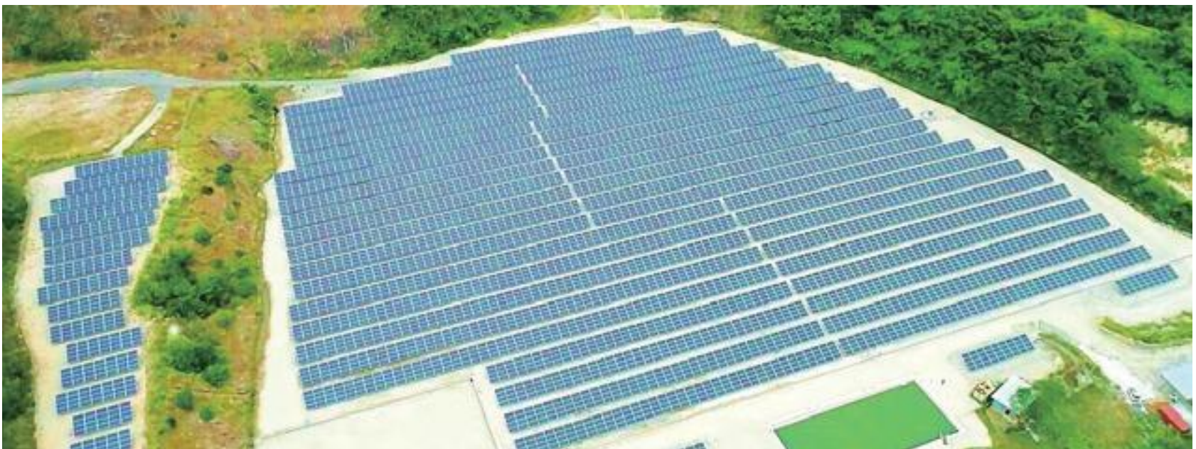
日本 3.24 MW 神埼光伏太阳能电站
