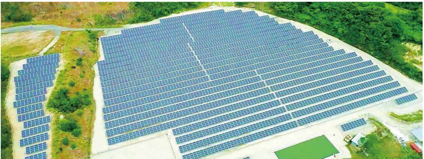
日本 3.24 MW 神埼光伏发电站项目
