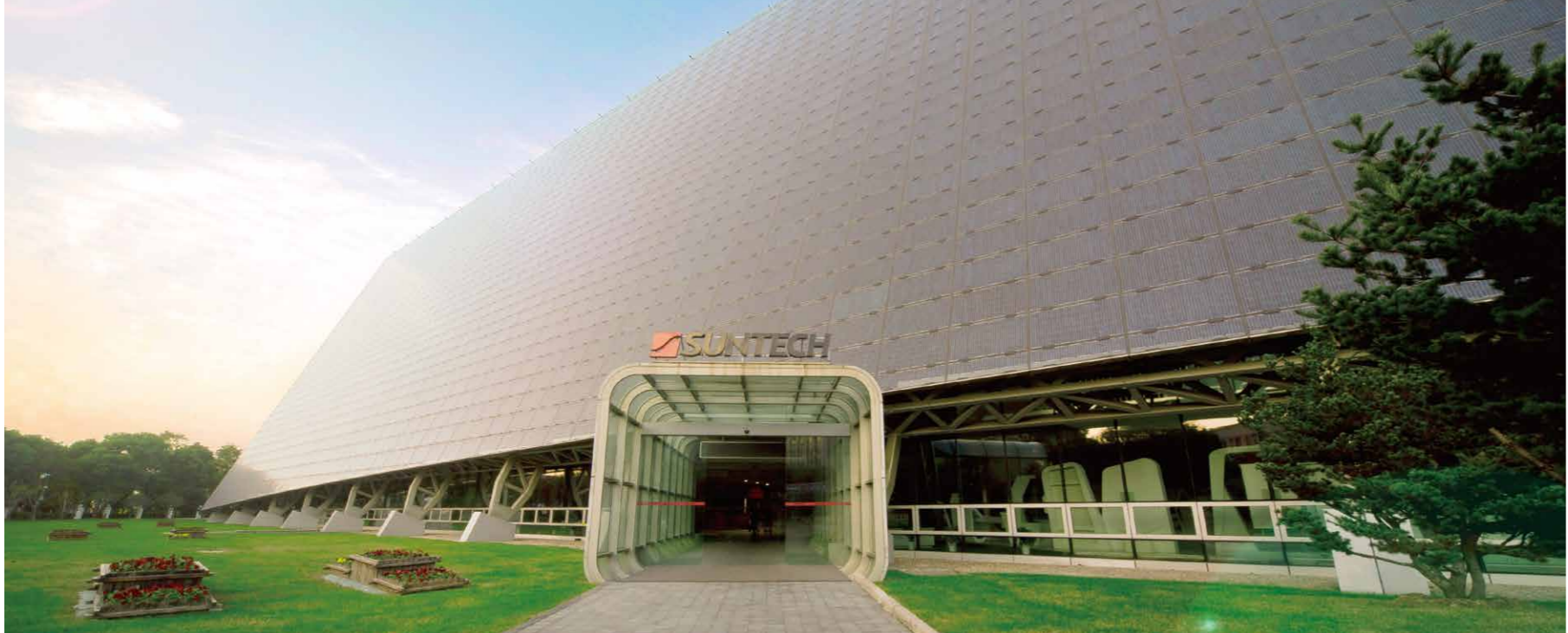
尚德电力光伏组件一体化项目
