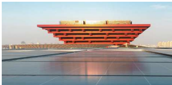
世博会中国馆光伏建筑 一体化项目
