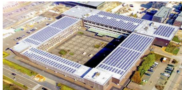
比利时-Genk市政厅屋顶太阳能电站项目
