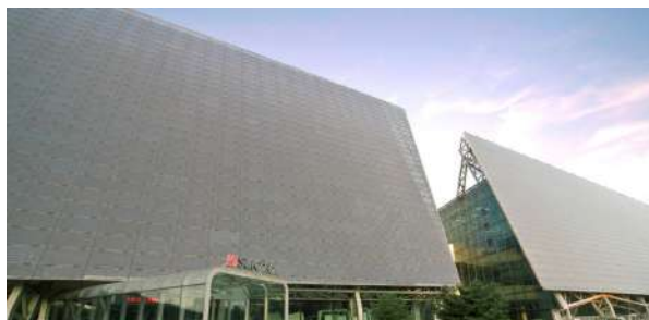
尚德总部生态大楼光伏建筑 一体化项目
