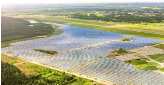
德国-Finow 太阳能电站项目
