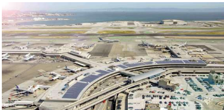
旧金山-国际机场T3航站楼屋顶太阳能电站项目
