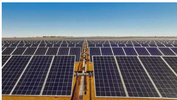
南非-Kimberly Droogfontein 太阳能电站项目
