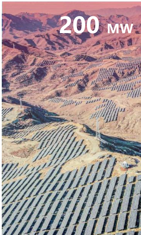
顺平安阳乡平价光伏发电项目
